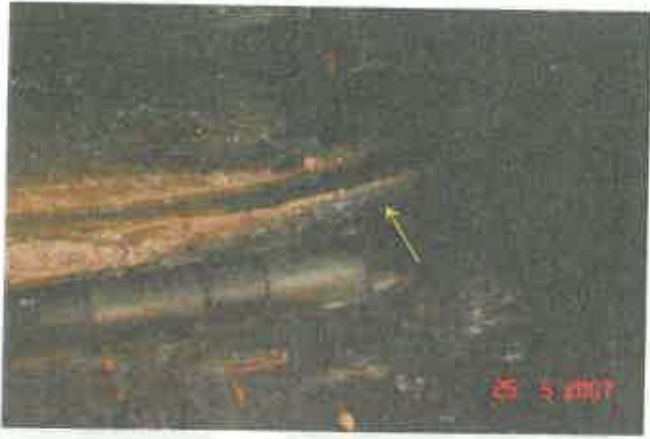
Photo n° 6 : résurgences en rein côté gauche au Pm 190
