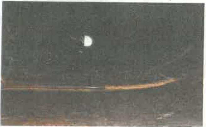
Photo n° 6 : résurgences en rein côté gauche au Pm 190
