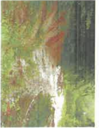
Photo n° 6 : arrivée d'eau vue vers la tête Germaine
